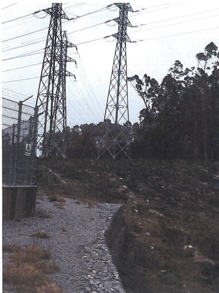
Fotografia 6 –Limpeza da biomassa vegetal em redor da subestação
