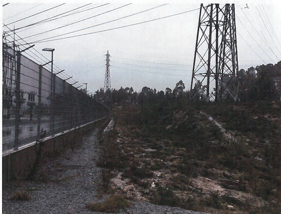
Fotografia 2 – Faixa lateral à Subestação
