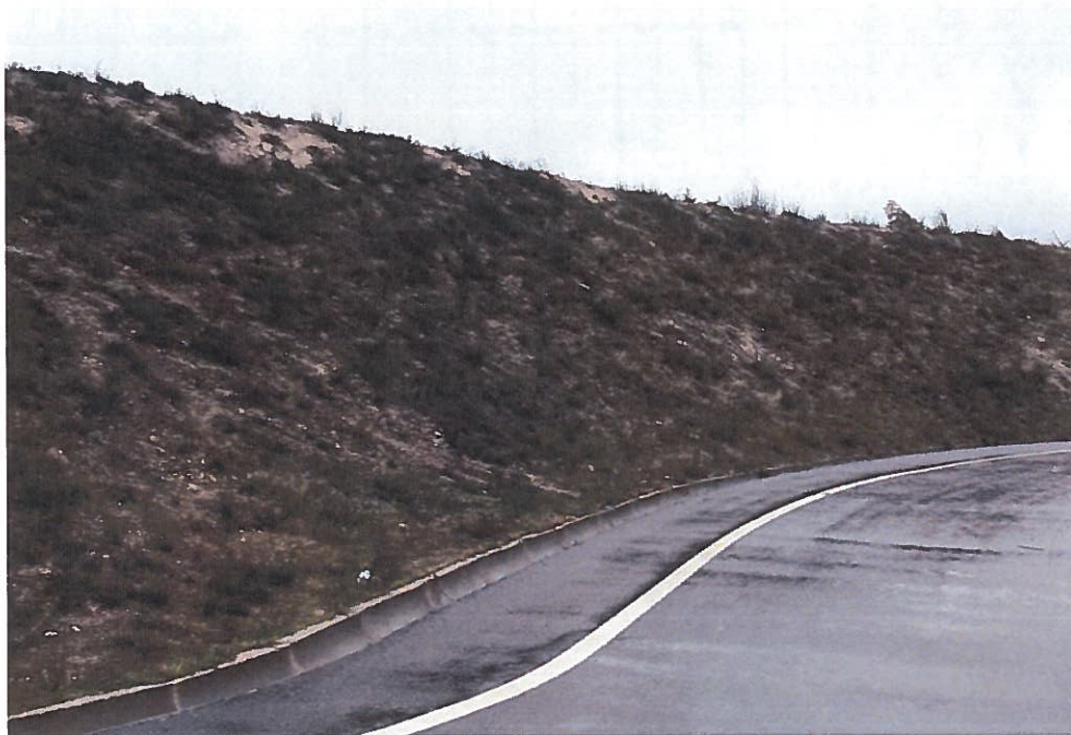
Fotografia 3 – Taludes da estrada de acesso à Subestação
