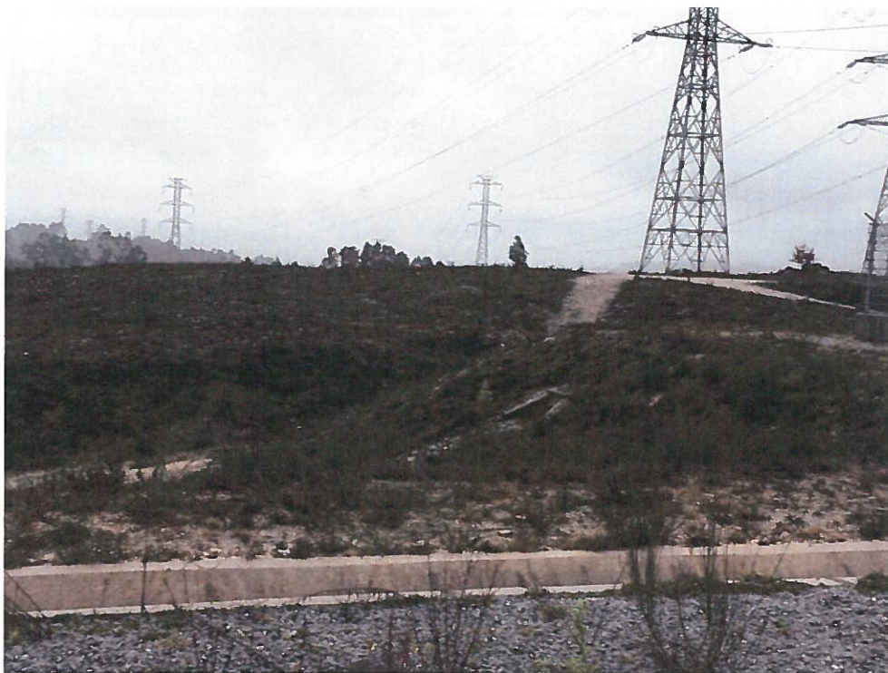
Fotografia 7 – Limpeza da biomassa vegetal em redor da subestação
