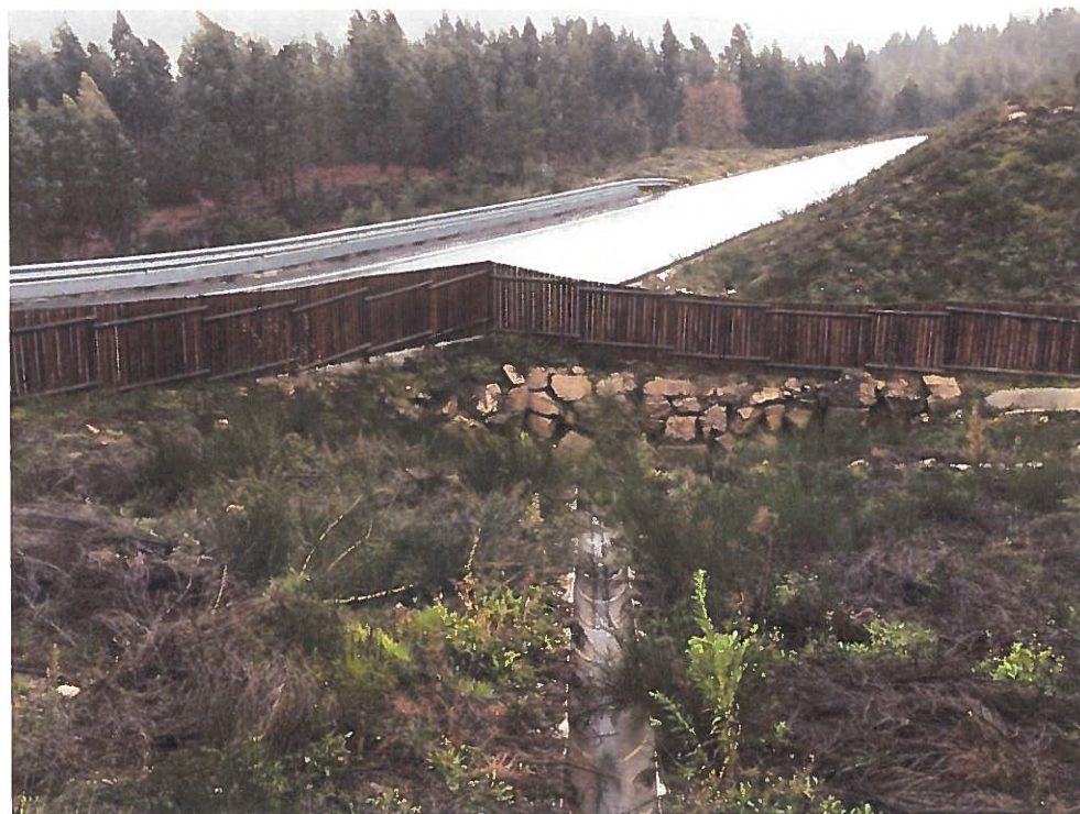
Fotografia 4 – Arranjo da linha de água
