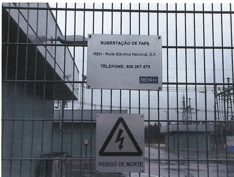
Fotografia 1 – Identificação da instalação com telefone de contacto
